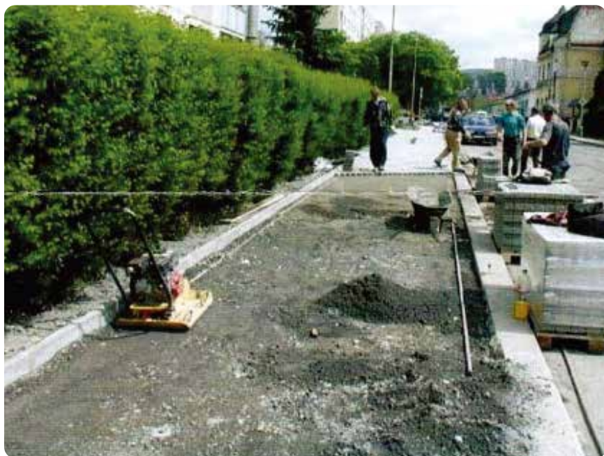
图26: 捷克共和国某公司使用飞灰和炉渣混合物作为人行道底层的宣传图片。该混合物中的二噁英和呋喃含量约为0.05-0.1 ppb世卫组织毒性当量。资料来源: Termizo公司寄给该地区市长们的信函, 该公司在利贝雷茨市经营市政废弃物焚烧业务。
